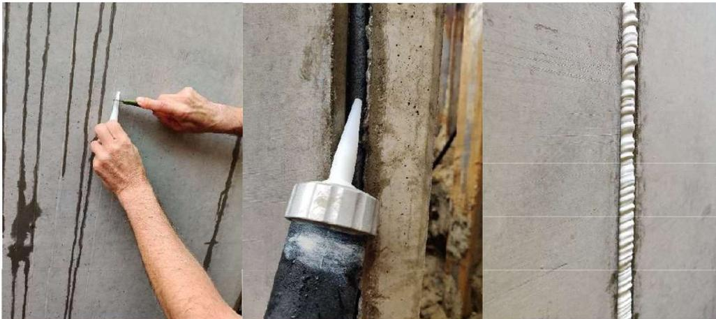
Nach Einbringung des jafo-HERMETIC WU Fugendicht, die Fuge mit der Spachtel glatt abziehen!
